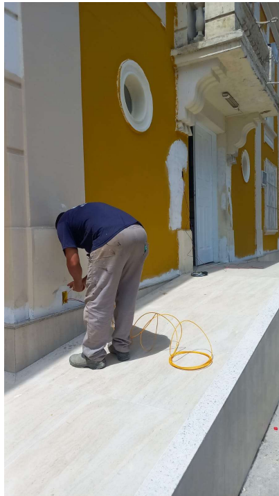
INSTALAÇÃO DE PONTO DE LUZ
