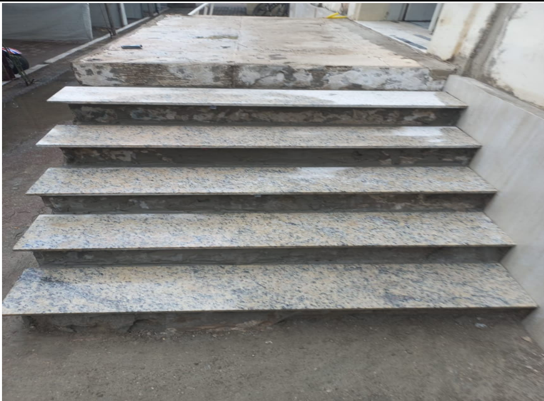
Pedras /patamar, rampa e escada
