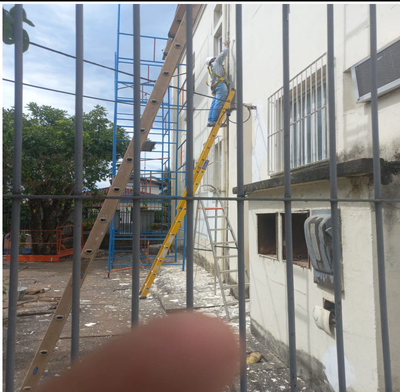
Preparação das paredes
